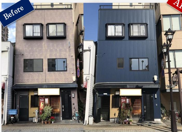
外壁の劣化で内部に雨水が板金を重ね張りするカバー工法で遮熱、遮音性も高まります。
